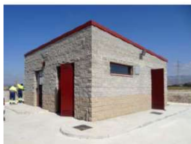
Ilustración 94. Instalación de la EDAR
